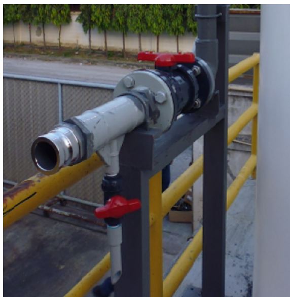
รูปที่ 3-6 ตัวอย่างชุดท่อรับโซดาไฟ ชนิดข้อต่อสวมเร็ว ขนาด 2 นิ้ว
